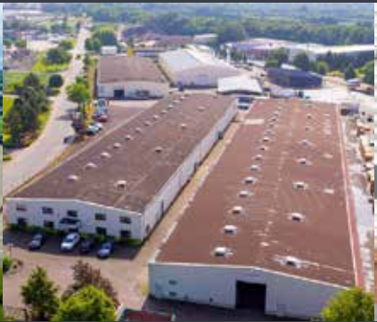
Büro- und Produktionshallen Werk 2, Dornierstraße 12, Hörstel
